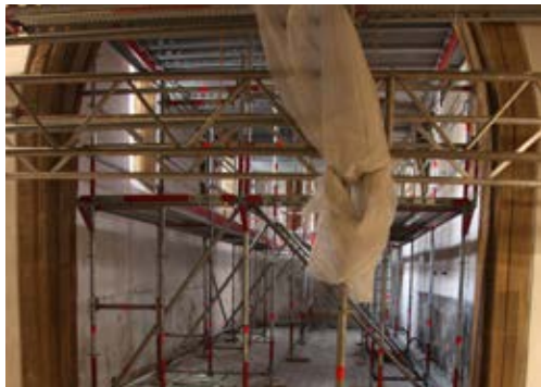
Die Annakapelle ist inzwischen eingerüstet. Über dem alten Dachstuhl der Kapelle wurde der neue errichtet.
