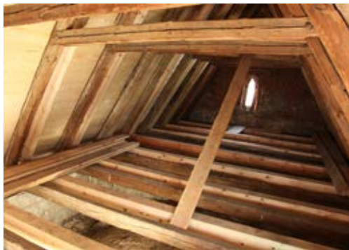
Die Annakapelle ist inzwischen eingerüstet. Über dem alten Dachstuhl der Kapelle wurde der neue errichtet.
